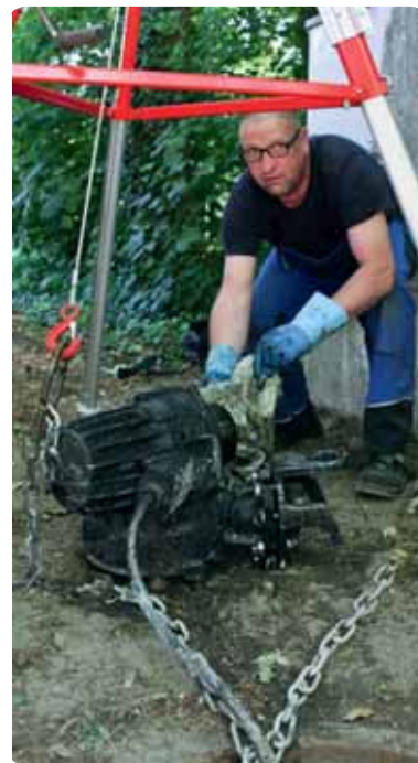
Abwassernetzmonteur Roland Bertram.
