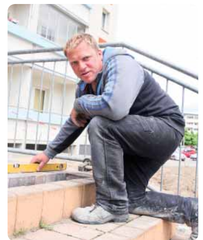
Steffen Ruschke aus Linow erneuert mit seiner Firma die Außenanlagen. Verwerfungen der Pflasterung wurden ausgeglichen.
