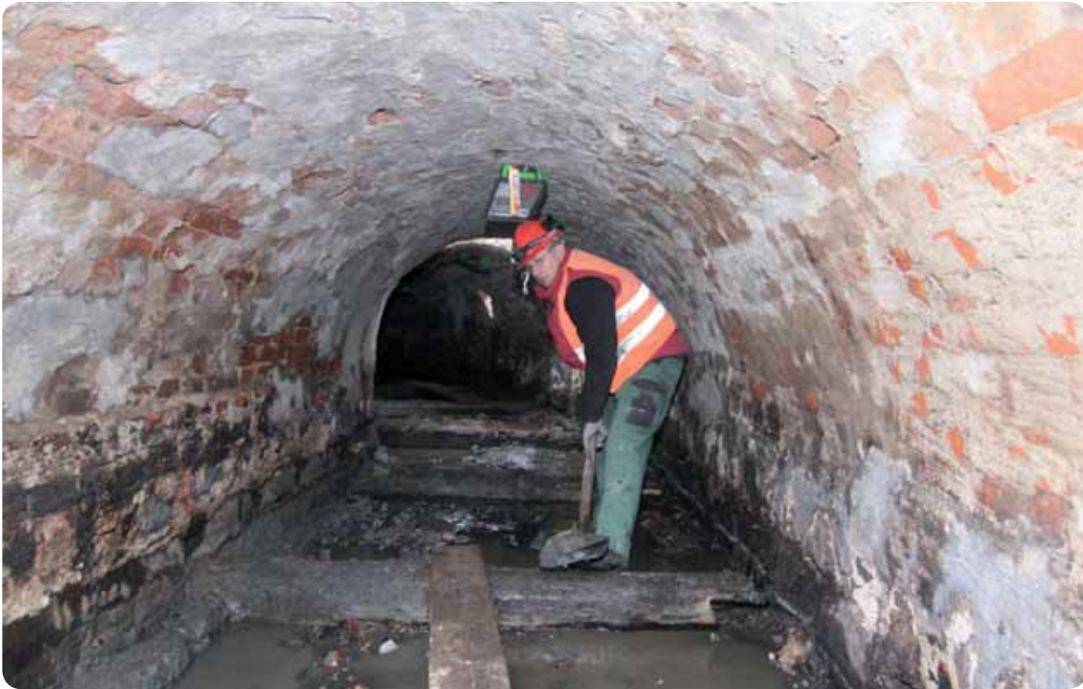
Hans-Dieter Kujat von der Firma HTK aus Wusterhausen bei der Reinigung des Klappgrabens.
