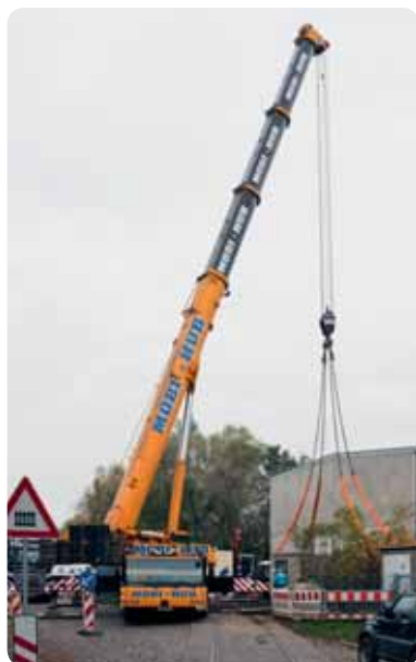
BHKW Ernst-Toller-Straße, die Trafostation wird komplett montiert angeliefert.
