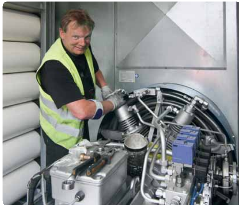
Anlagentechniker Karsten Scheikel wartet den Verdichter der Erdgas-Tankstelle Nauener Straße.
