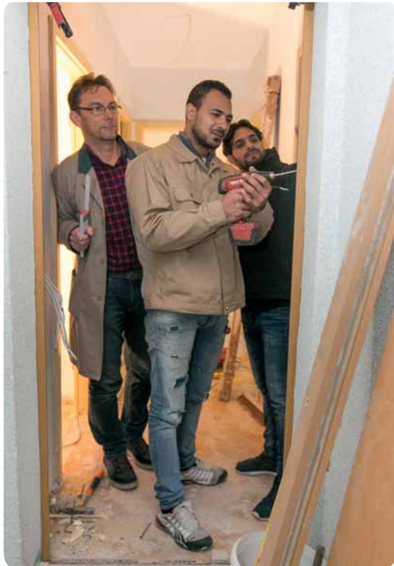
Torsten Leitow (links), Ahmed Badry und Salim Alhasib tauschen eine alte Tür aus.
