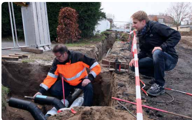
Die Stadtwerke-Mitarbeiter Bernd Müller (links) und Michael Koark bei der Baustellenkontrolle.
