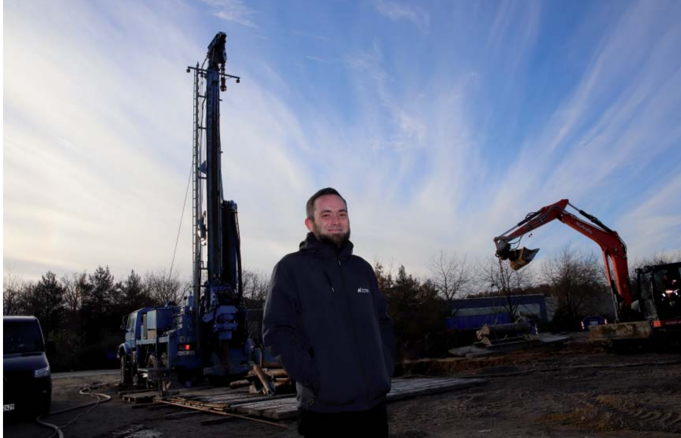
Ludwig Zab am Ort der Bohrungen. Ende 2026 soll die Geothermie etwa 70 Prozent des Energiebedarfs des Neuruppiner Fernwärmenetzes decken.
