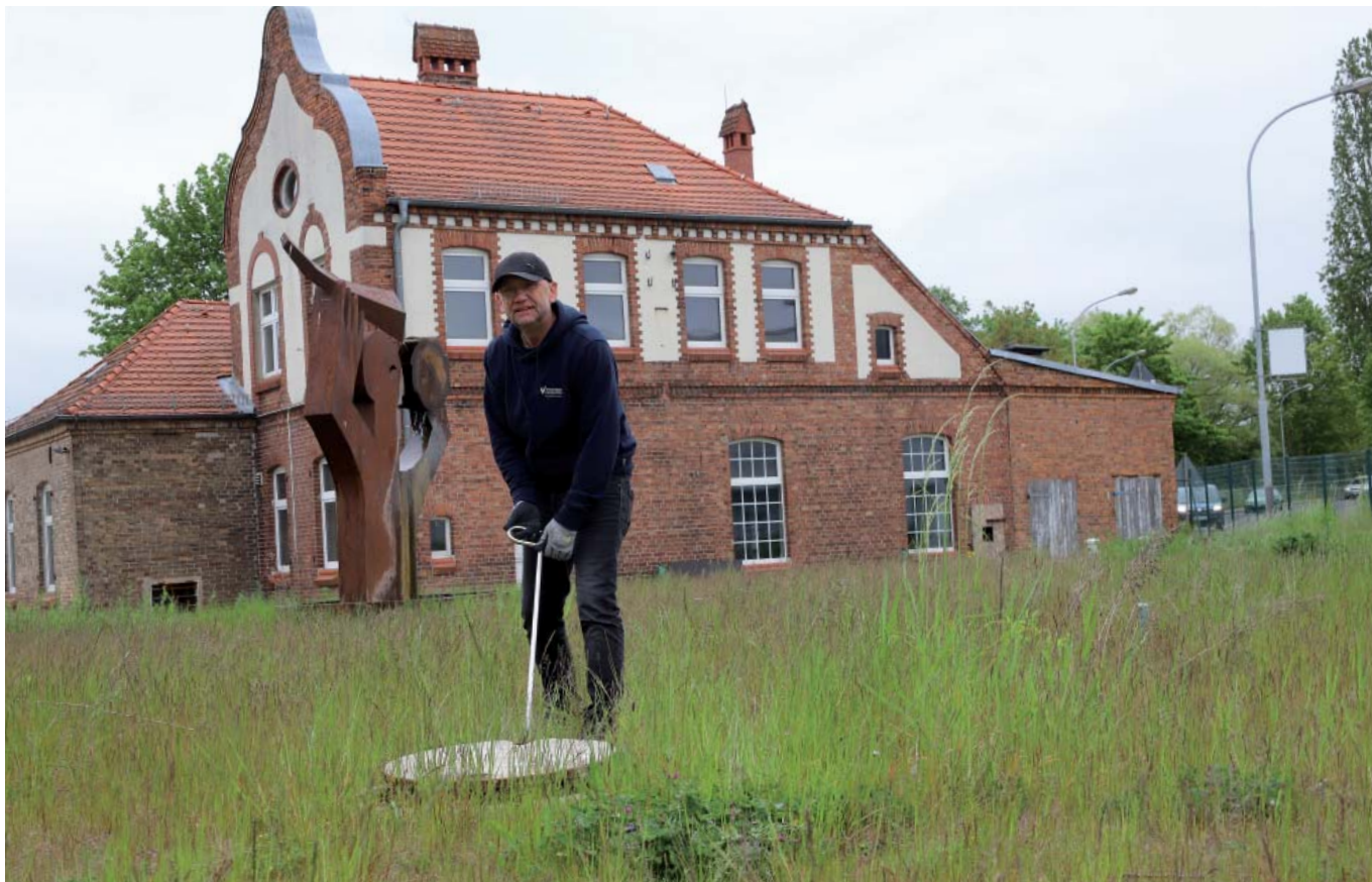
Torsten Maeles öffnet den Deckel zum noch leeren Regenwasserspeicher am Abwasserpumpwerk.
